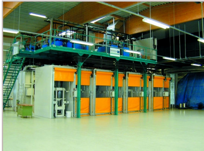
ClearRIM Produktion Linie bei der Firma HIB in Bruchsal
