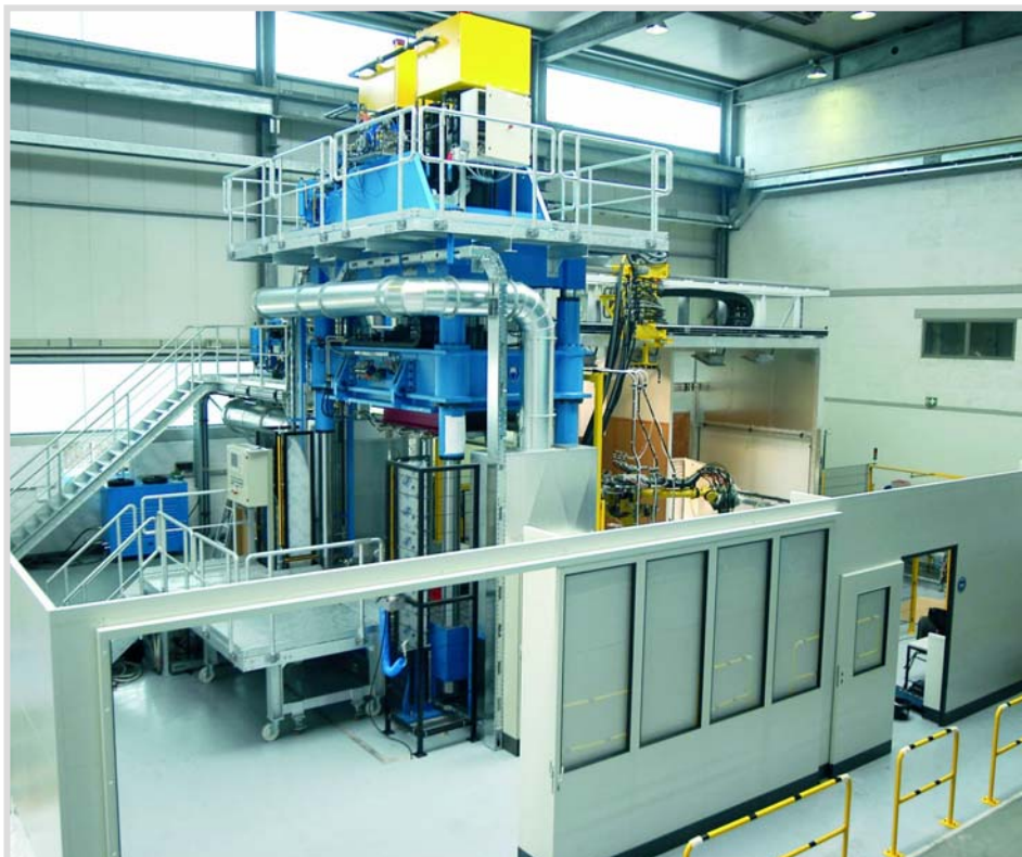
Das neue PUR-Sprüh- und Dosierzentrum der Hennecke GmbH
